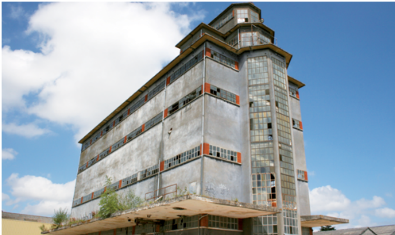
Façades sud et ouest (CAUE71, 2007)
